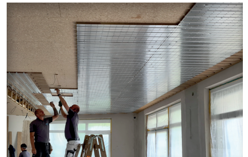
Deckenheizung auf OSB Untergrund
