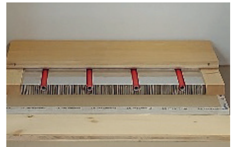
Fußbodenheizung Verlegung unter Dielenboden
