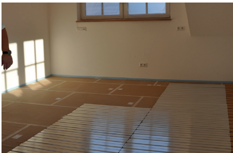
Fußbodenheizung Montage auf PhoneStar
