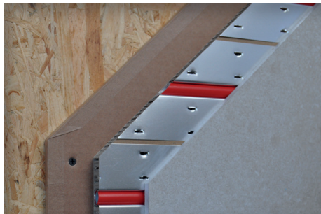
Wandheizung auf OSB und PhoneStar
